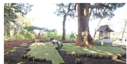
周辺表土保護、張芝状況
