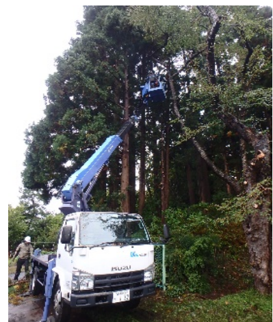
周辺樹木伐採、剪定状況
