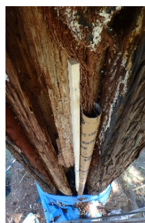
不定根パイプ誘導
